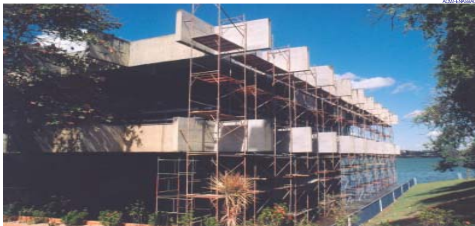
Reforma do prédio principal da ASBAC-BSB
